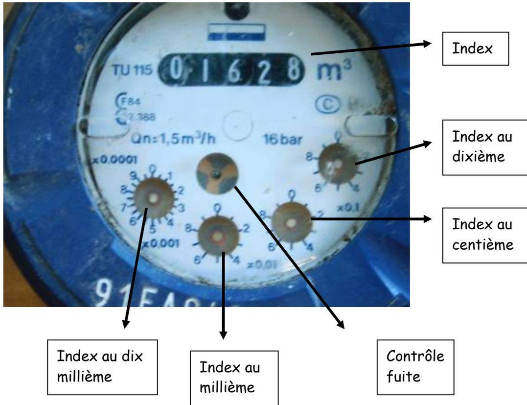
Les chiffres en noir désignent l'index (partie entière). La partie décimale se lit via les différentes aiguilles. Une roulette est également présente sur le compteur. Elle permet de vérifier si de l'eau est utilisée et donc de déceler des fuites éventuelles.
